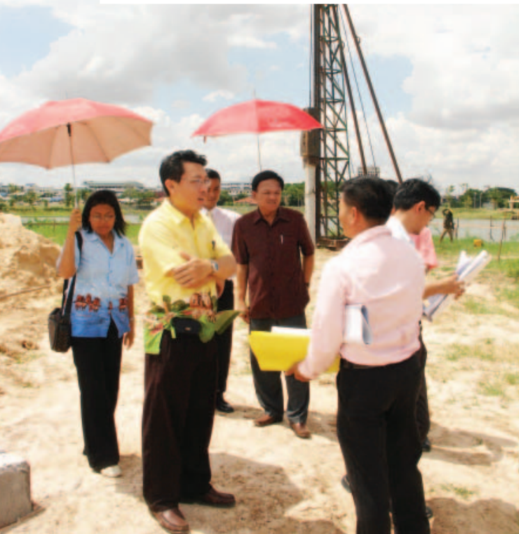
นายอภิคม สุพรรณพงศ์ ผู้ตรวจราชการ เขต ๑๔ ลงพื้นที่เพื่อตรวจติดตามโครงการก่อสร้างอาคารอเนกประสงค์ สวนสาธารณะเฉลิมพระเกียรติ อ.เมือง จังหวัดสุรินทร์ ในวันที่ ๓๐ มิ.ย. ๒๕๕๓
